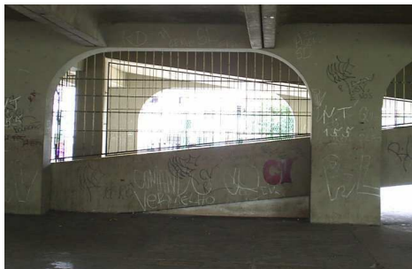
Figura 6: Rampa de acesso ao interior do CIEP Elis Regina. A marcação do território pelo Comando Vermelho se expressa nas paredes.
