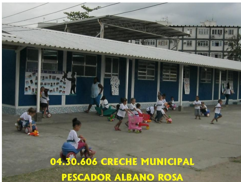
Fotografia 01 – Fachada da creche
