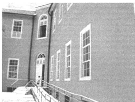
Os fundos da escola, no canto o anexo reconstruído.
