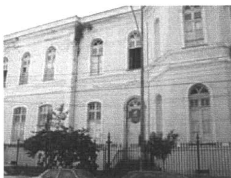
A escola estava em péssimo estado
