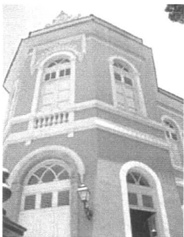
A fachada reformada
