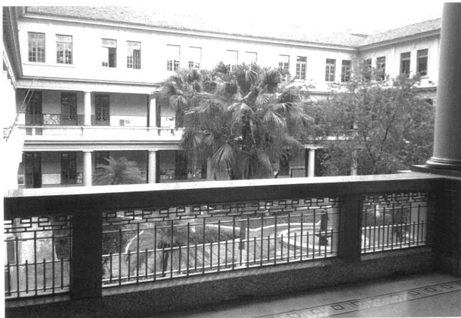
Figura 5 – Vista do corredor do segundo andar
