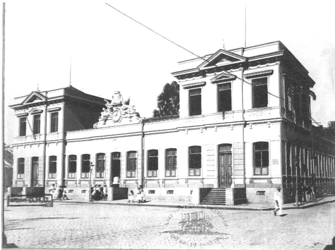
Imagem 1: Escola São Sebastião situada na freguesia de Sant'Anna, ainda no império. Em 1897, o prédio abriga o primeiro grupo escolar republicano como Escola Benjamin Constant.
