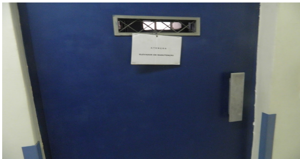
Fotografia 12: Elevador de acesso aos andares superiores
