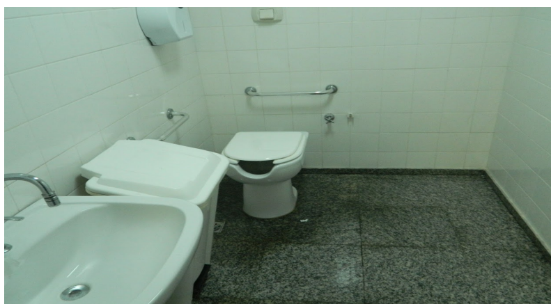
Fotografia 7: Vista interna do banheiro acessível
