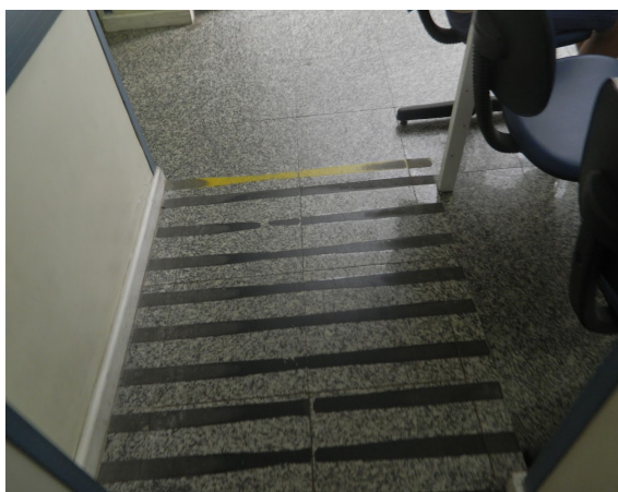
Fotografia 8: Rampa de acesso
