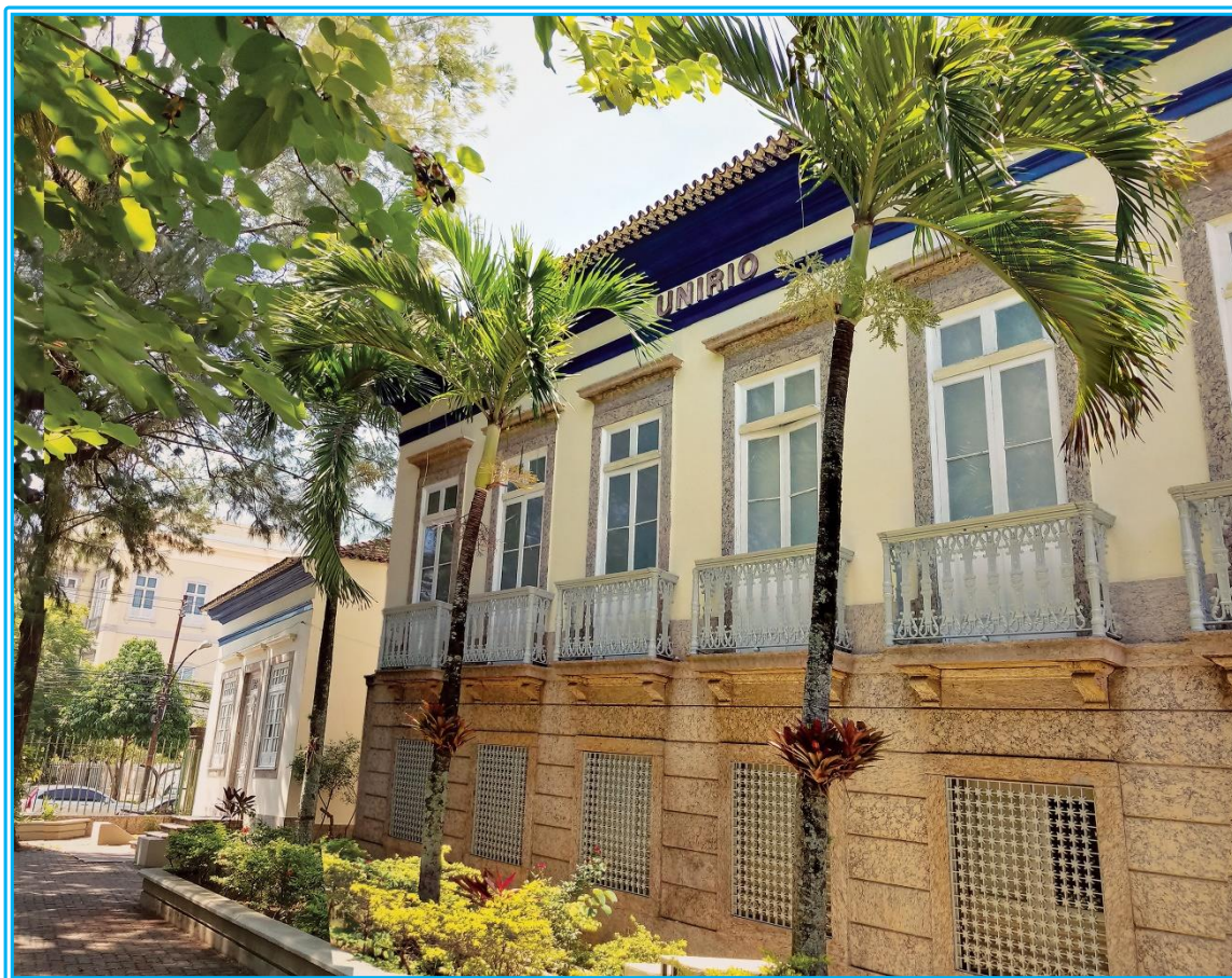
Figura 41 - Prédio da Reitoria da UNIRIO
