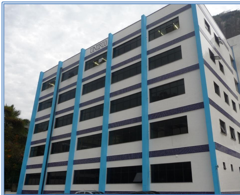
Figura 7 - Prédio do CCET
