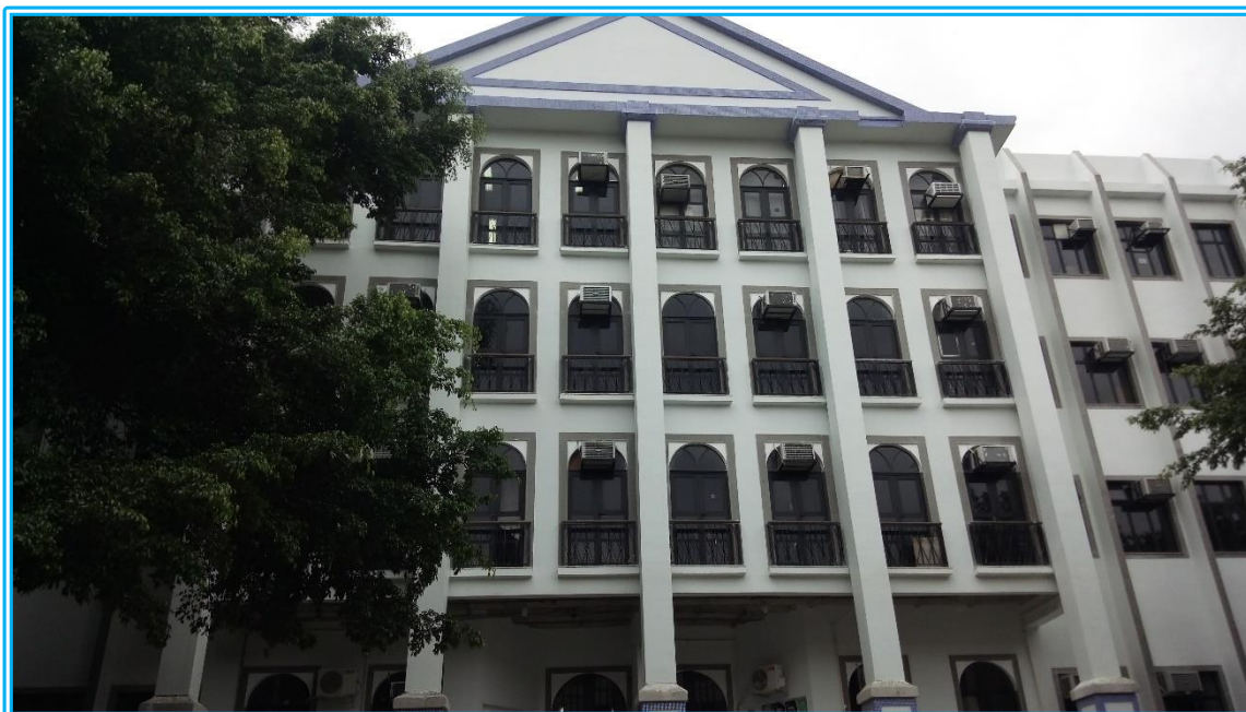
Figura 8 - Prédio do CCH
